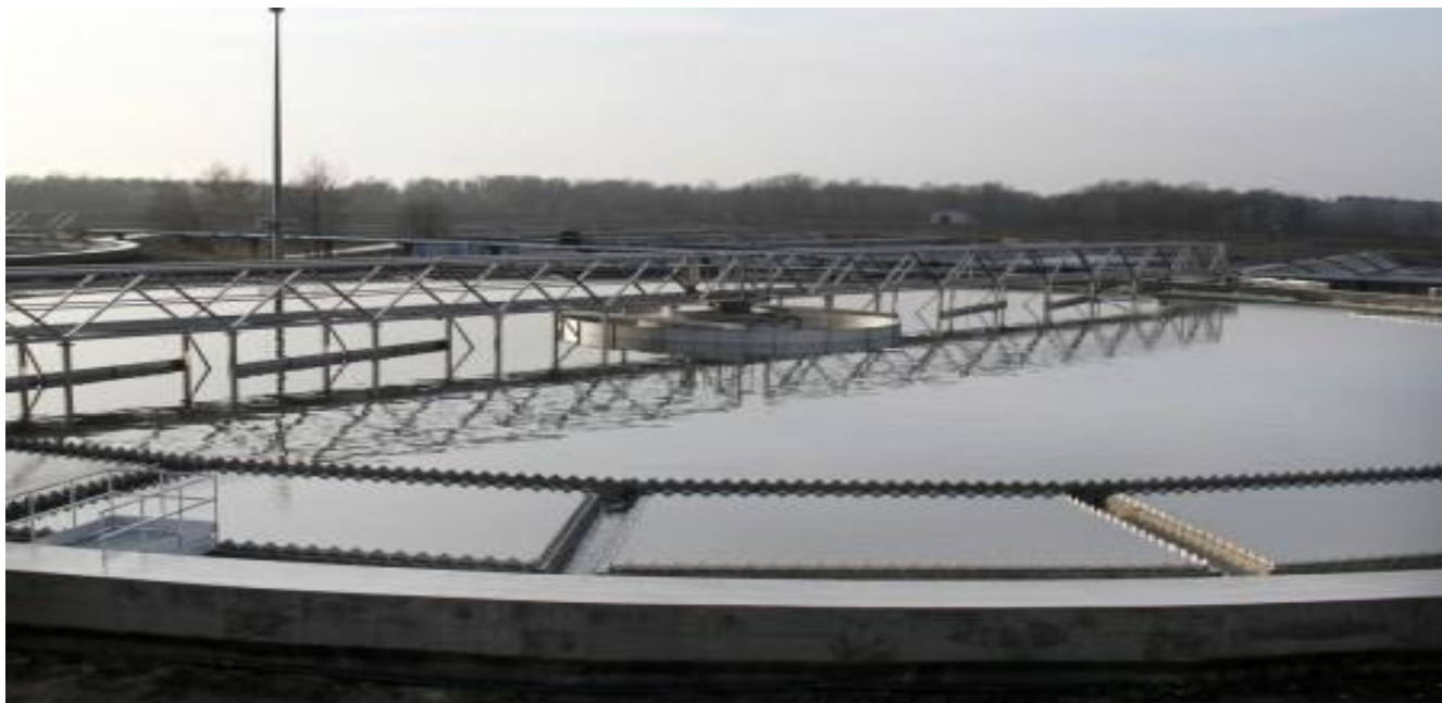
Рис. 3.26. Очистные сооружения в городе Гвардейске
